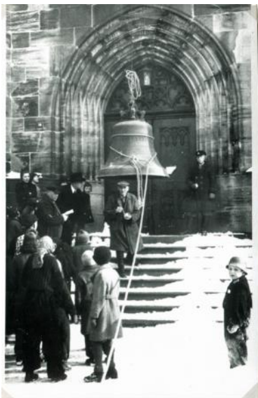
Herablassen der ersten Glocke vom Turm der Stadtkirche.
